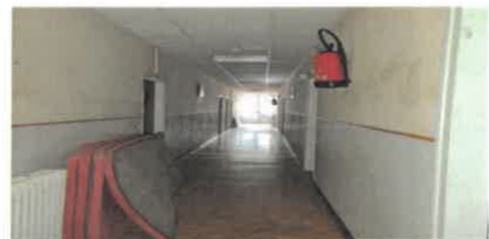
Couloir RDC desservant les gîtes
